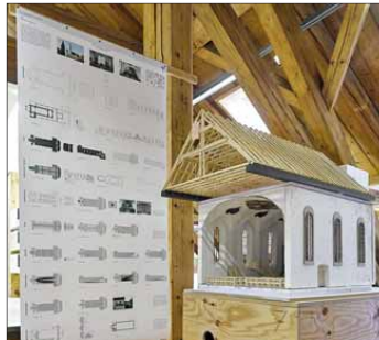
Dachkonstruktion der EPFL und Raummodell der Architektur-Werkstatt kombiniert zeigen, wie Johannes Grubenmann bei der katholischen Kirche St. Vinzenz in Eschenbach (1754) einen stützenfreien Raum geschaffen hat.
